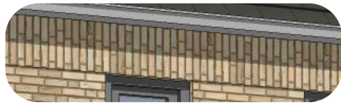
metselwerk boven kozijnen
