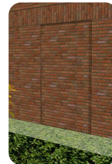
metselwerkdetail 'dichtgemetseld kozijn'
