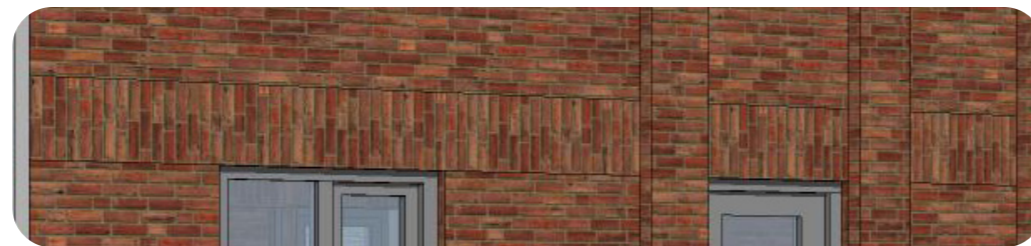
metselwerkdetail boven de kozijnen
